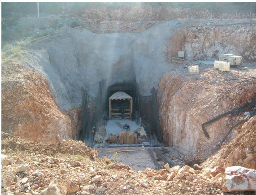
Slika 1. Izlaz iz tunela
